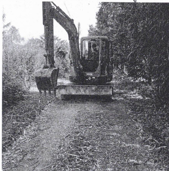
การปรับเกลี่ยถนนสายบ้านกระทิง ซอย 2 หมู่ 5 ตำบลพลวง
